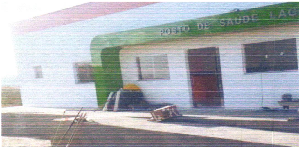
FOTO 01 - Revestimento metálico em alumínio composto (Alucobond), e=0,3mm, pintura Kaynar 500 composta por seis camadas, inclusive estrutura metálica auxiliar em perfil de viga "U" de 2" - fornecimento e montagem
