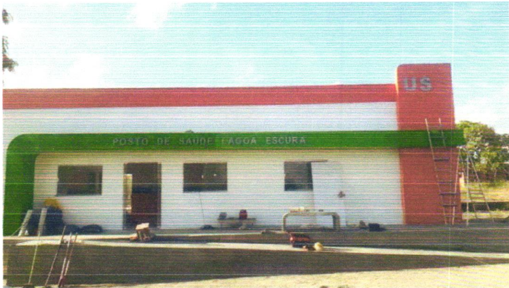
FOTO 03 - Letra em alumínio 45 x 45cm - instalado
