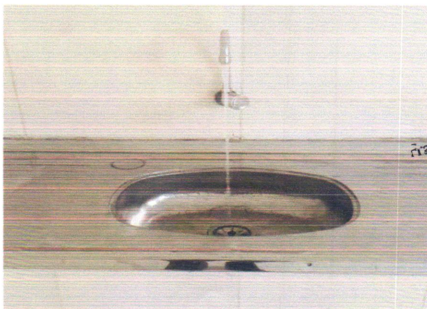
FOTO 14 - Pia de cozinha com bancada em aço inox, dim 1,20x0,60m c/ 01 cuba, válvula cromada, sifão cromado e torneira cromada, concretada e assentada. Rev.04
