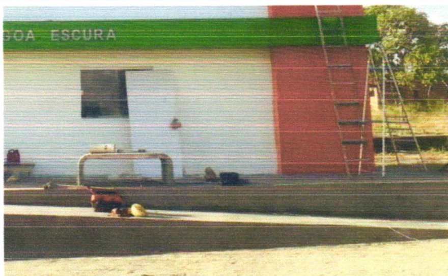
FOTO 09 - Banco de concreto pre-moldado com pintura, sem encosto (padrão emurb)
